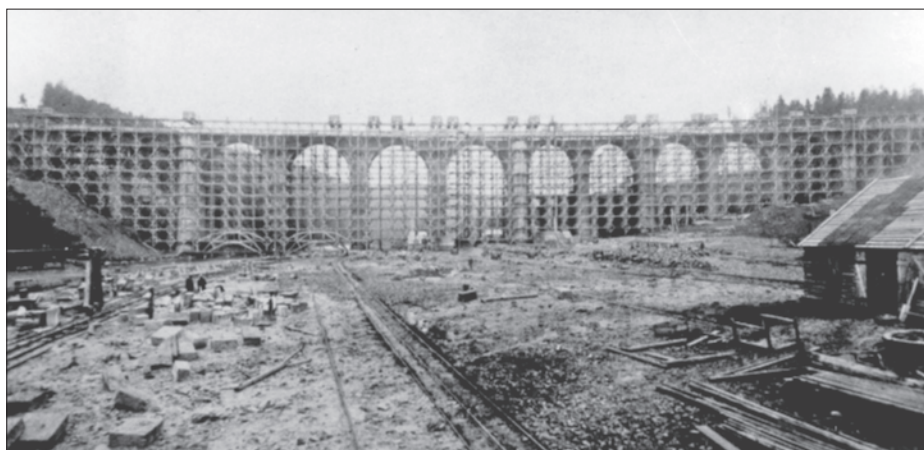
Bau des Hetzdorfer Viaduktes (vermutlich Frühjahr 1868). Im Vordergrund erkennbar die vom Bahnhof Flöha aus gelegte sechs Kilometer lange Förderbahn.
