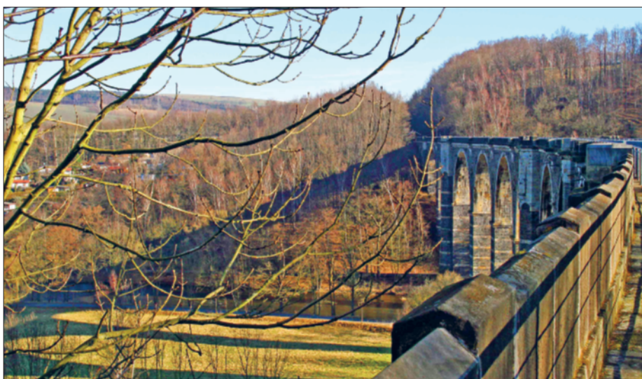
Aufgrund der komplizierten Hanglage der Flöha musste der Hetzdorfer Viadukt in einem großen Bogen mit einem Radius von 572 Metern gebaut werden.
